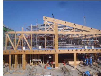
大断面材を使用した架構
