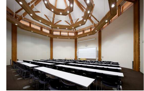
2本の登り梁を露出した架構
