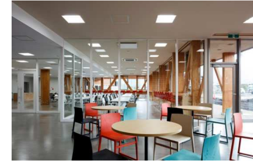
柱・筋カいを露出した室内(ラウンジ・学生ホール)
