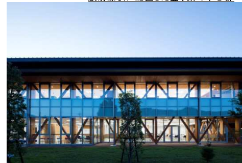
カーテンウォール越しに柱・筋カいが視認できる
