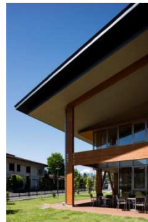
軒を深くし露出した柱・梁
